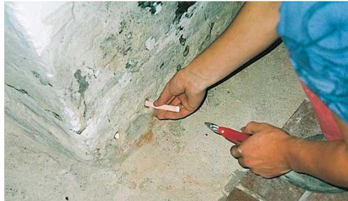
Abb. 2: Einsetzen der Kapillarstäbchen
