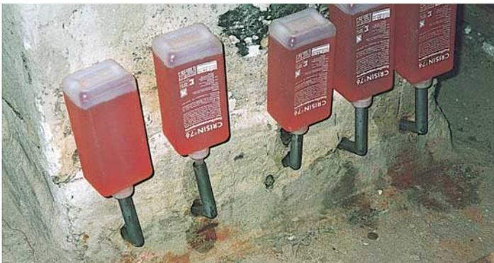
**Abb. 6: Aufsetzen der Kunststoff-Kartuschen auf die Winkel – und Erfolgskontrolle nach dem Entfernen**
