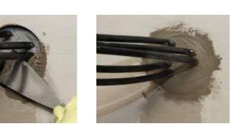
6 ... und dauerhaft abgedichtet.
