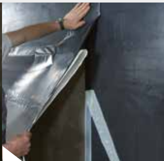
Vgradnja membrane
