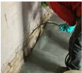
3. Injektiranje KÖSTER IN 8
