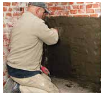
4 KÖSTER KD 1, tesnilni premaz: 2 sloja (drugi sloj po 30 minutah)
