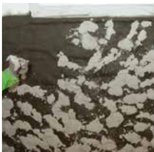
Nanos osnovnega obrizga KÖSTER Sanirni omet-špric
