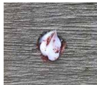
KÖSTER Crisin krema je čvrsta. To je velika prednost kadar delamo s kartušami ali alu črevi. Tudi če naneseemo preveč materiala v izvrtino, krema ne bo stekla po ometu, kar bi lahko povzročilo masten madež na površini. Odvečen material je mogoče enostavno odstraniti. Luknje se zatesnijo s hitrovezno malto, stene pa preplastijo s sanirnimi ometi.
