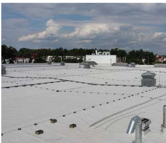
Hidroizolacija ravne strehe s KÖSTER TPO, REAL Supermarket, Nemčija
