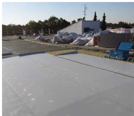
Hidroizolacija ravne strehe s KÖSTER TPO, EDEKA Supermarket, Nemčija
