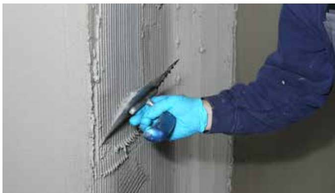
Notranja kletna hidroizolacija
