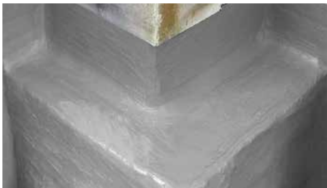
Zaščita temeljev in podnožij
